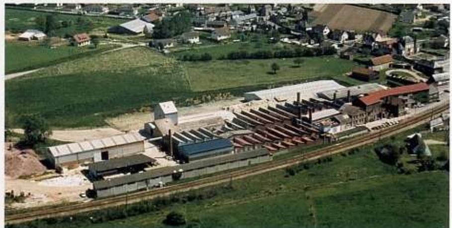
L'usine de Ferrières-en-Bray, aujourd'hui / The factory nowadays
