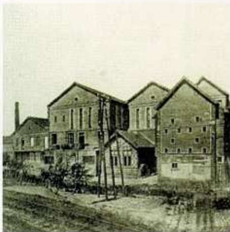
L'usine voici 200 ans... / The factory 200 years ago
